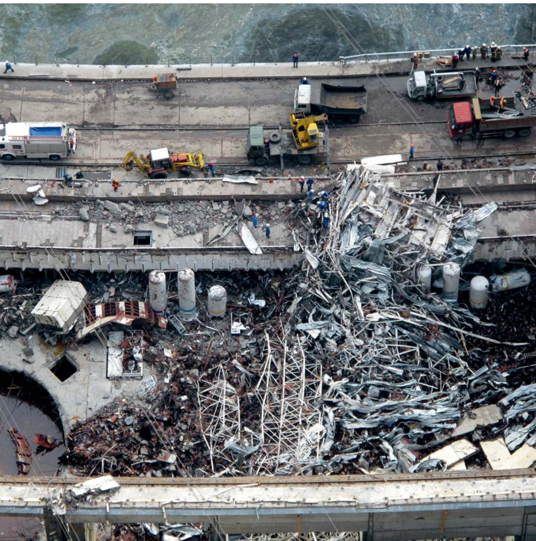
Саяно-Шушенская ГЭС после аварии
